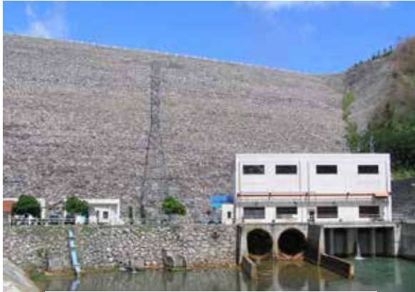
Main Dam pada bendungan Batutegi, Lampung
