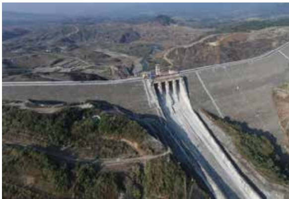
Main Dam pada bendungan Jatigede, Sumedang
