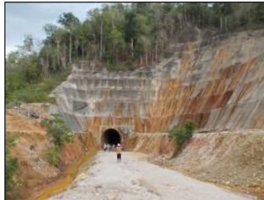
Bendungan Bintang Bano (Nusa Tenggara Barat)
