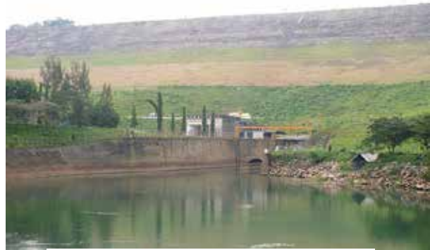
Main Dam pada bendungan Juanda, Purwakarta
