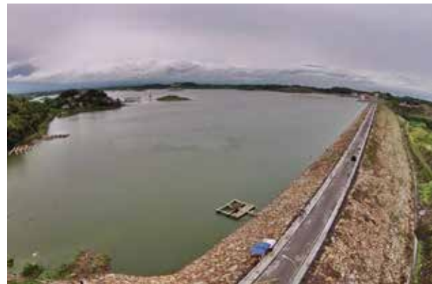
Main Dam pada bendungan Pandanduri, Lombok
