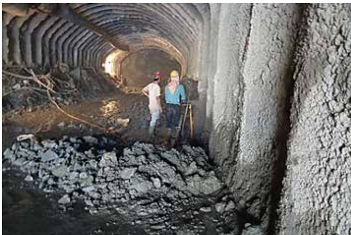
Foto 4. Pelaksanaan konstruksi Terowongan pengelak
