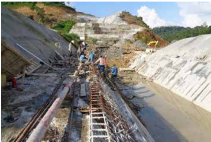
Foto 3. Pekerjaan pengecoran bagian dari open channel saluran pengelak.
