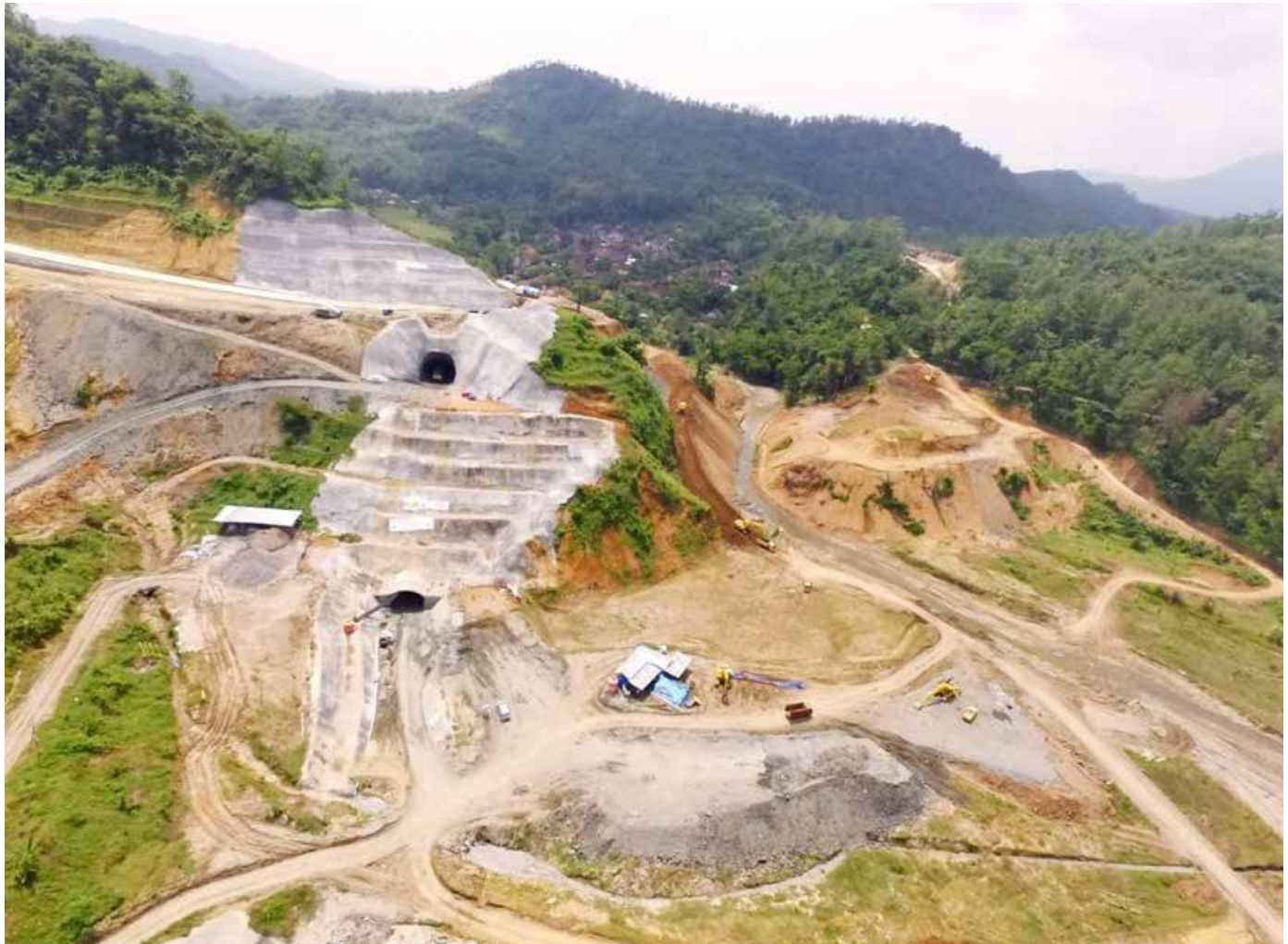
Foto Udara Proyek Bendungan Kuningan
