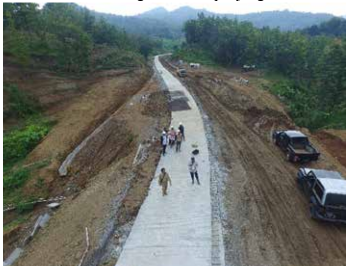
Foto 2. Jalan akses rigid beton sepanjang 3 km.
