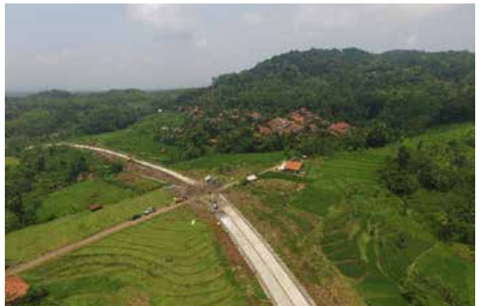
Foto 1. Jalan akses rigid beton sepanjang 3 km.
