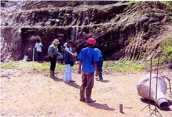
Foto 1 - Pengukuran kelurusan titik-titik pemboran dinding halang (diaphragm wall)
