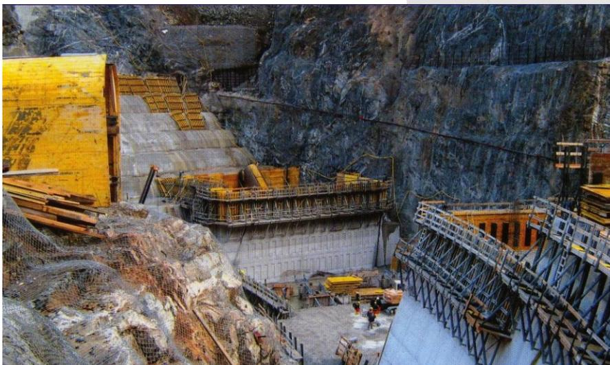
dibangun untuk memenuhi kebutuhan air TSANKOV KAMAK HYDRO POWER PLANT. Bendungan dengan ketinggian 130,50 m, panjang puncak bendungan sepanjang 480 m dan memerlukan timbunan beton sebanyak 600.000 m<sup>3</sup>, pembangunan mulai pada
