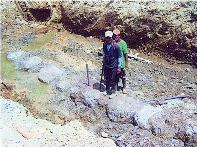
Foto 7 - Deretan beton plastis tampak membentuk dinding halang (*diaphragm wall*)
